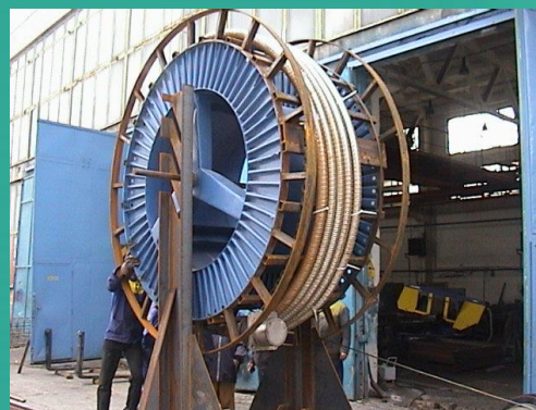
Prefabrikácia kábla Projstar CH-13 Železničná estakáda Šenkvice
