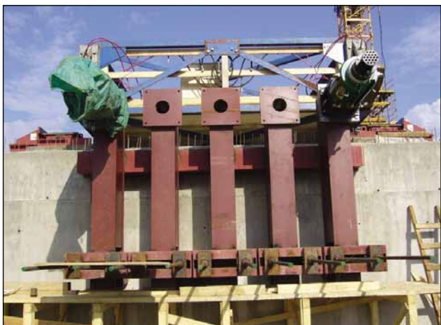
Obr. 6 Pohľad na kotevný rošt pre hydraulické lisy Fig. 6 View of anchorage grillage for hydraulic jacks
