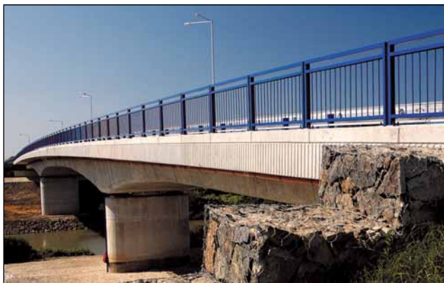
Obr. 4 Most D 203 v obci Vysoká nad Uhom
