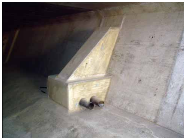
Obr. 3 Deviátor voľných káblov Fig. 3 External tendons deviator
