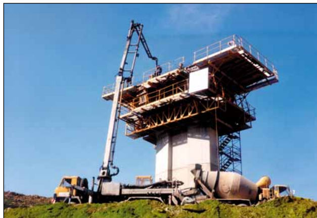
Obr. 2 Betonáž zárodku
