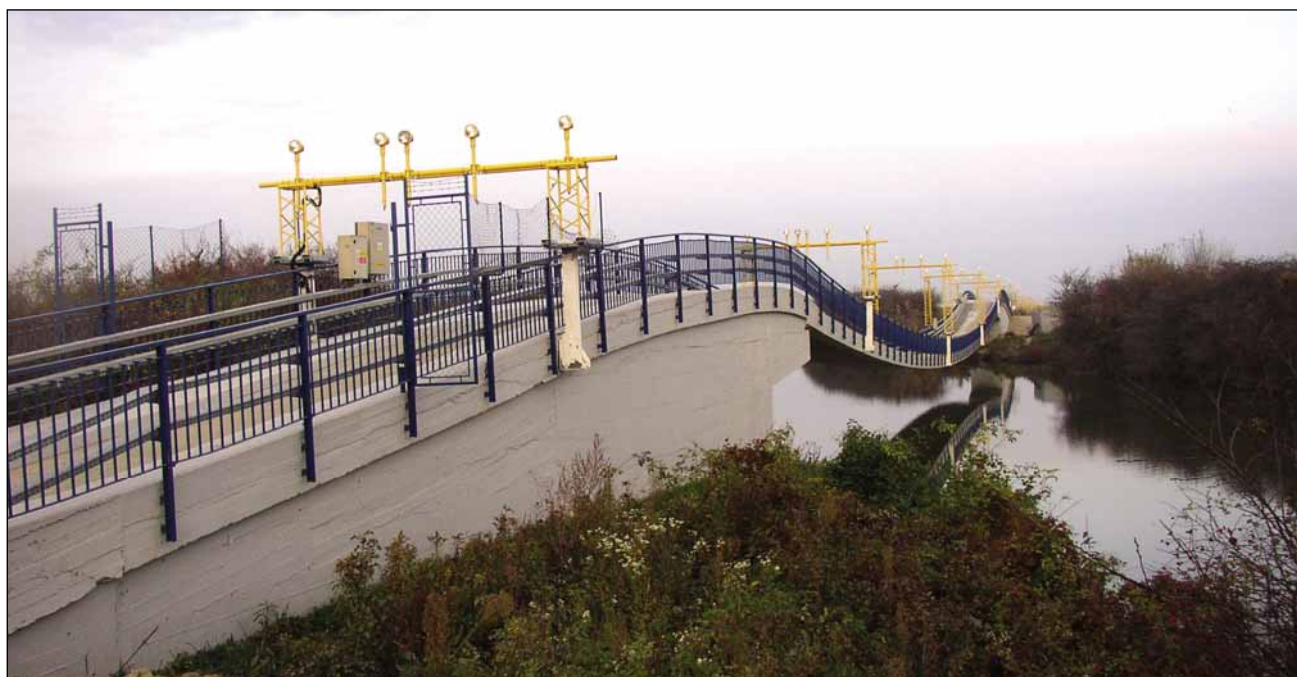
Obr. 3 Pohľad na lávku po oprave
