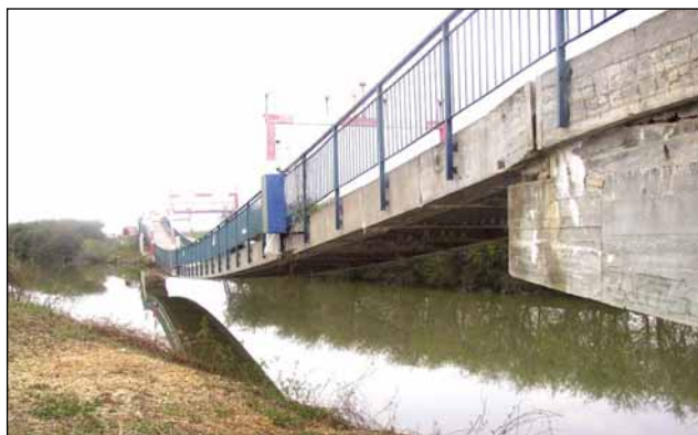
Obr. 1 Pohľad na lávku – pôvodný stav Fig. 1 View of footbridge – original state
