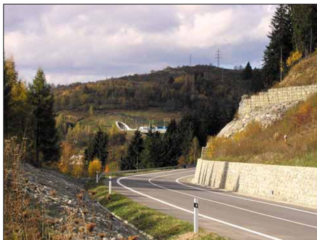
Obr. 1 Zárez s cestou k východnému portálu tunela Horelica Fig. 1 A set-off with the road to the eastern portal of the Horelica tunnel
