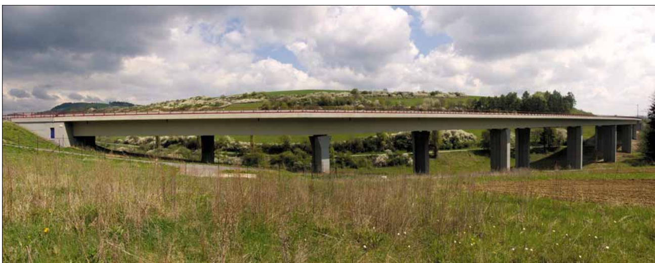
Obr. 1 Most D 214 pri obci Fričovce
