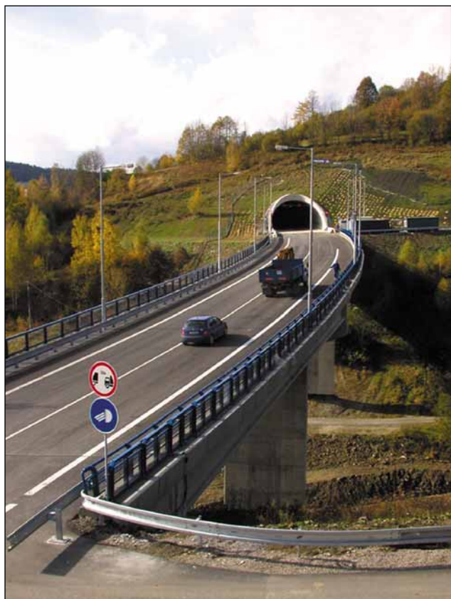
Obr. 2 Most k východnému portálu tunela Horelica Fig. 2 The bridge to the eastern portal of the Horelica tunnel
