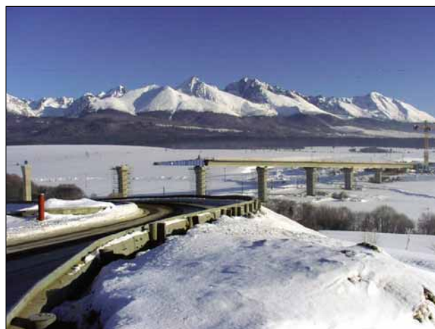
Obr. 8 Panoráma rozostavaného mostu na začiatku roku 2006 Fig. 8 The bridge under construction at the beginning of 2006
