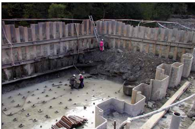
Obr. 3 Výstavba – kotvená stavebná jama, príprava podpernej skruže
