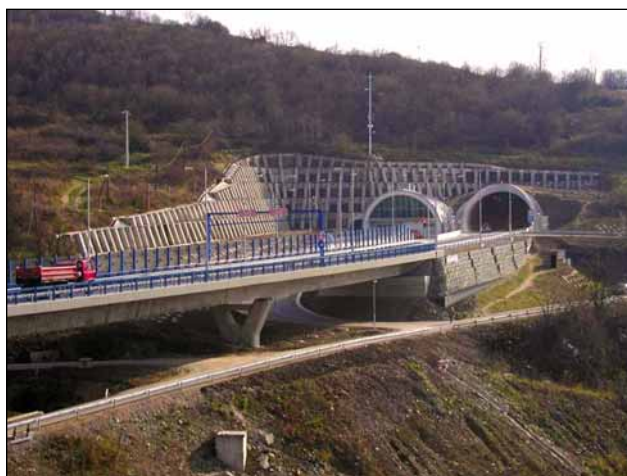
Obr. 3 Západný portál tunela Horelica Fig. 3 The western portal of the Horelica tunnel
