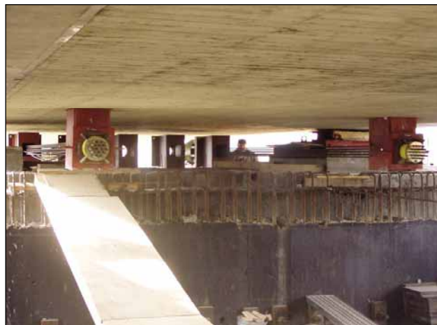
Obr. 7 Kotvenie výsuvných lán do nosnej konštrukcie Fig. 7 Anchorage of launching cables
