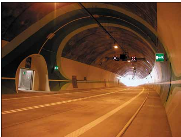
Obr. 4 Pohľad do tunela Horelica
