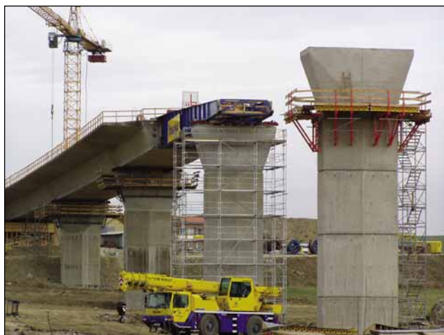
Obr. 4 Pohľad na časť vysunutej konštrukcie Fig. 4 Piers and partially launched superstructure
