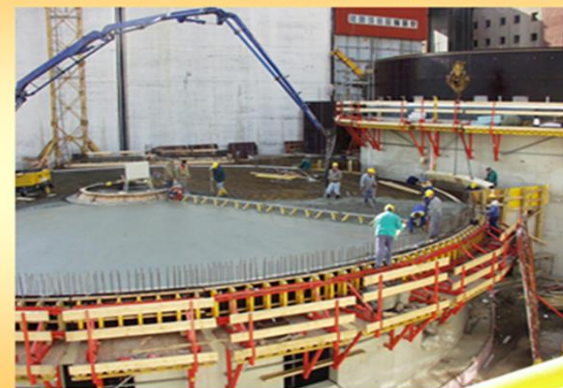
BETONÁŽ KRUHOVEJ STROPNEJ DOSKY
